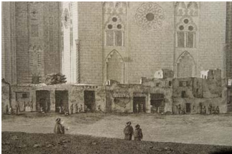
Le Kaire : [gravīra] : vue de la mosquée de Souldan Hasan.
